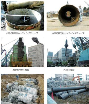
水平切断刃付カッティングチューブ
