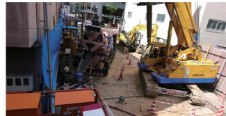
狭小地での生コン打設
