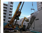
鉄筋建込状況
